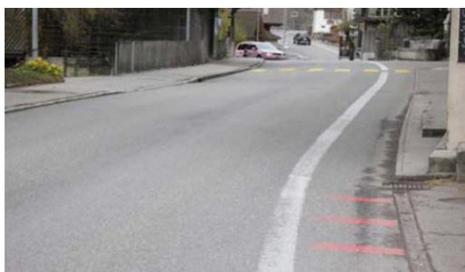
Die graue Linie im Bild oben kann mit einer weissen Randlinie verwechselt werden. Zudem entsprechen die punktuell angeordneten roten Querstriche nicht der VSS-Norm. Die graue Linie «drückt» den Verkehr gegen die Strassen-
