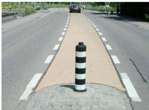
Der Mehrzweckstreifen (MZS) ist eine in der Fahrbahnmitte befindliche Fläche. Diese kann mittels Markierung oder durch farbige Gestaltung der Strassenoberfläche von den Fahrstreifen abgetrennt sein. Der MZS kann in der Regel von einer Vielzahl von Verkehrsteilnehmenden benutzt werden, unabhängig von der Verkehrsart. Er dient Fussgängern zum Überqueren der Strasse sowie den Radfahrern und dem motorisierten Verkehr zum Linksabbiegen oder -einbiegen (aus beiden Richtungen).
